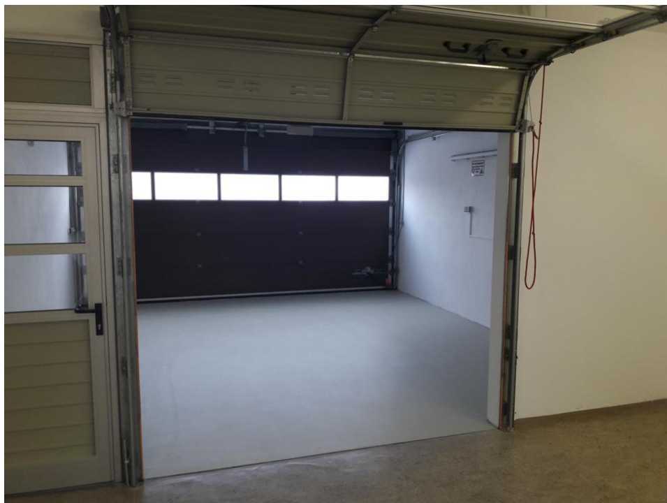
Eingang Rolltor mit Schleuse
