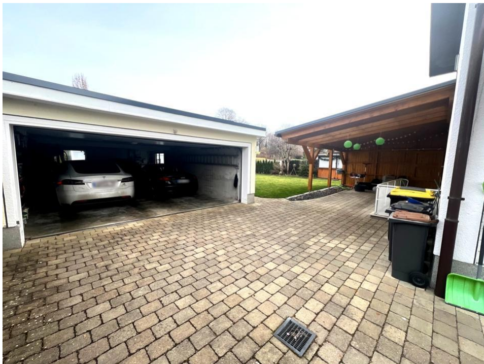
4- Fachgarage und Carport
